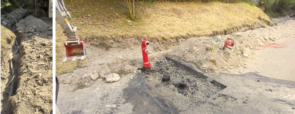
Abbildung 11: Sanierung der Trinkwasserleitung ins alte Kraftwerk
