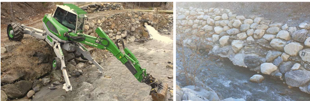
Abbildung 10: Reparatur der Bachbett- Rollierung
