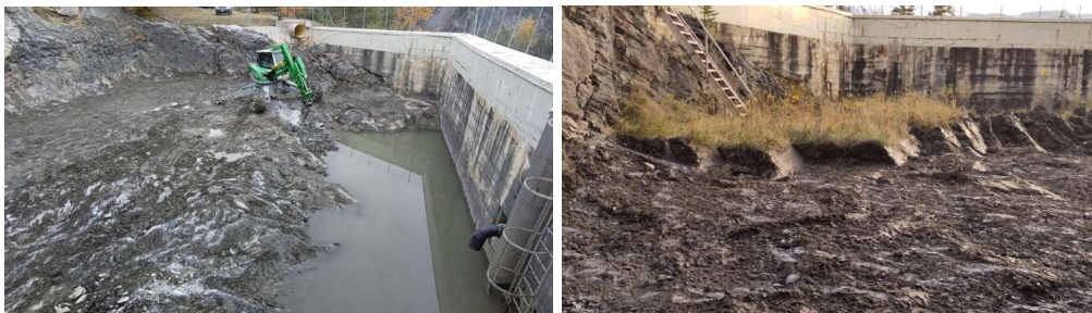
Abbildung 16: Ausbaggern des Überlaufbeckens
