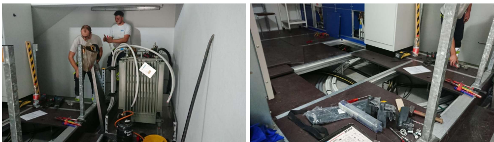
Abbildung 14: Transformatoraustausch
