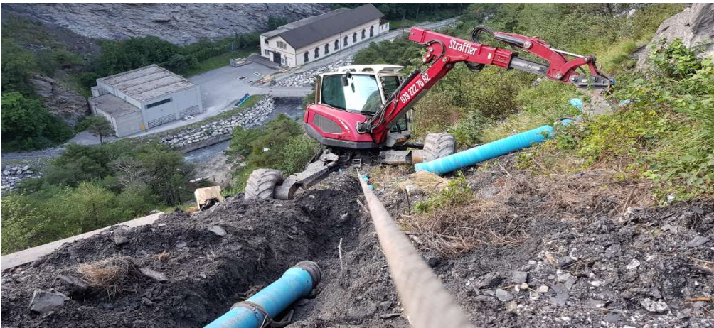
Abbildung 16: Bauarbeiten KWKW Varen.
