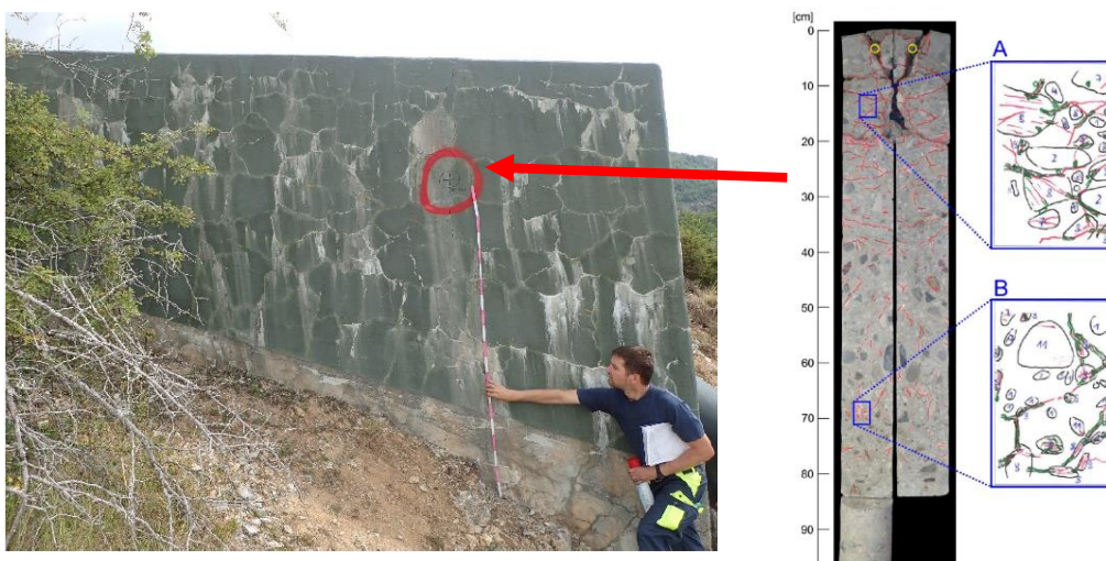
Abbildung 10: Impressionen Kernbohrungen an Fixpunkt WP2
