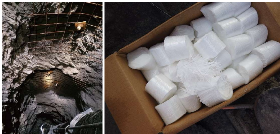
Abbildung 11: Sicherung des Stollens mit Armierung und Kunststofffasern
