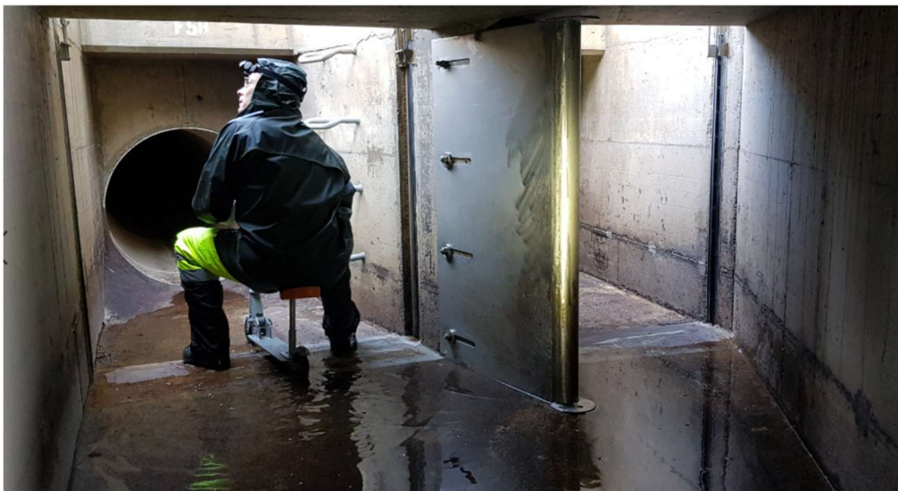
Abbildung 12: Begutachtung Fenster 5 - Verteilbauwerk
