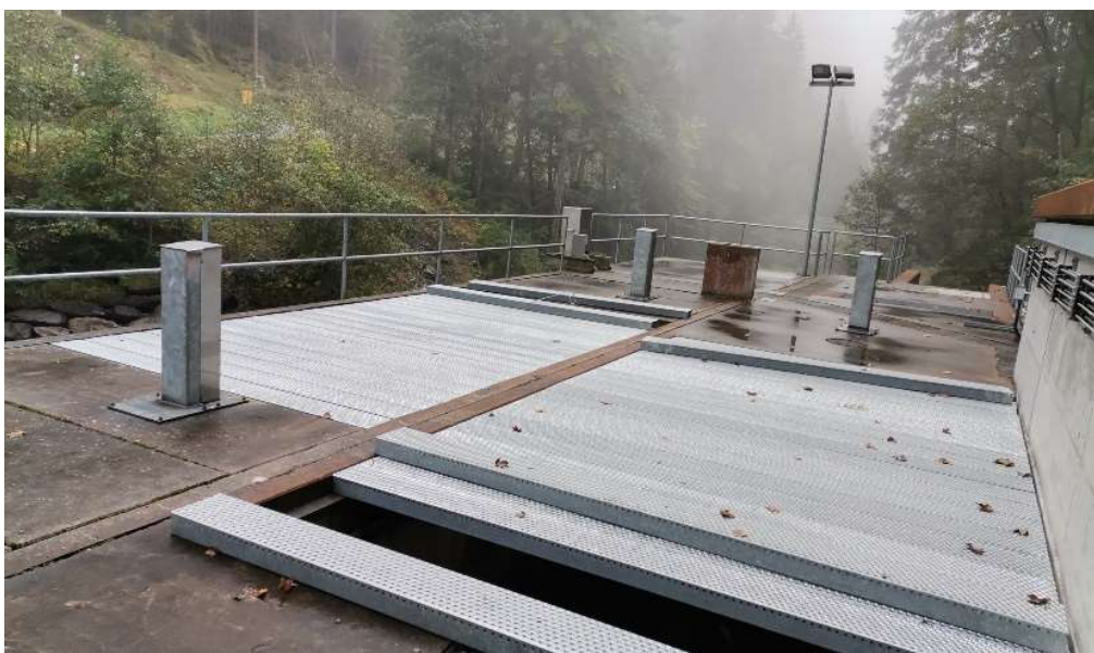
Abbildung 13: Neue Bodenabdeckungen Entsander
