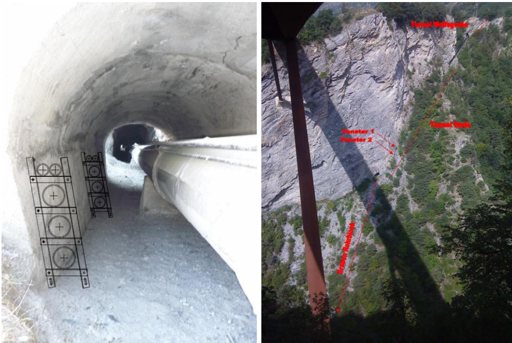
Abbildung 9: Zu sanierende Stollenabschnitte im Bereich Duden-Zentrale.
