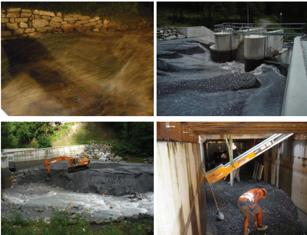
Abbildung 6: Auswirkungen des Hochwasserereignisses vom 24./25. Juli 2010.
