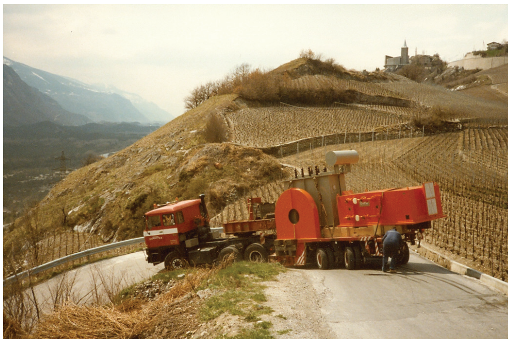
Abbildung 6: Rücktransport des sanierten Transformators nach dem Steinschlag 1995.
