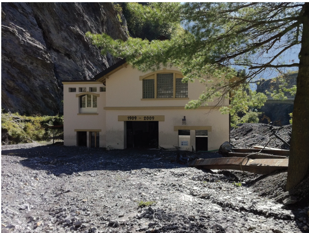
Abbildung 15: Die alte Zentrale nach dem Hochwasser 2011.
