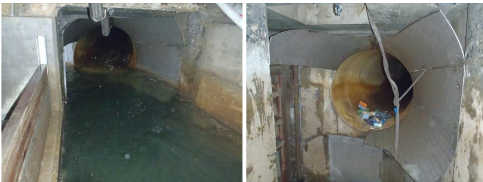
Abbildung 6: Optimierung des Wasserlaufes durch einen Einlauftrichter im Bauwerk Miliüt.
