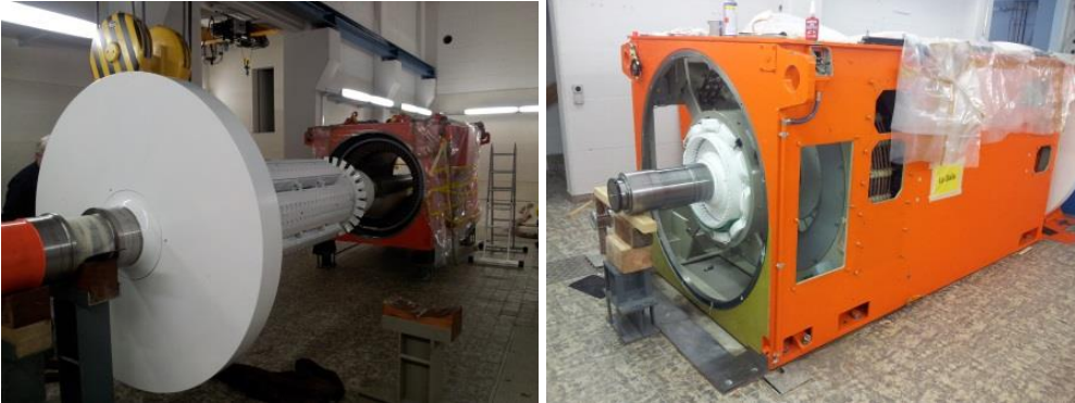
Abbildung 7: Montage des Generators.
