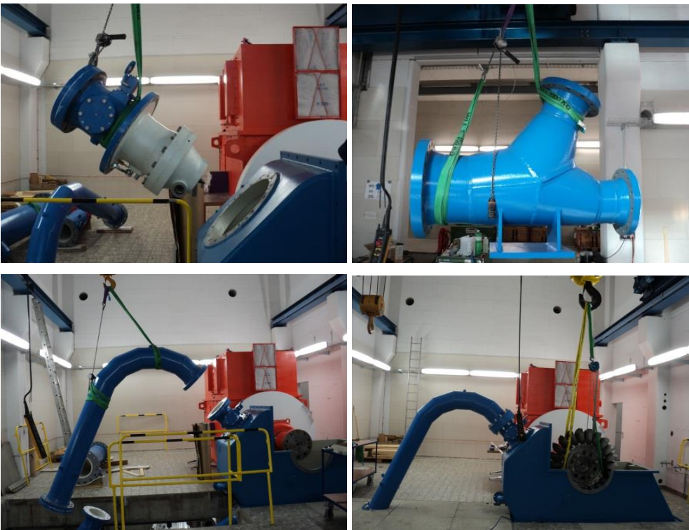
Abbildung 8: Montage der nassen Anlagenteile.
