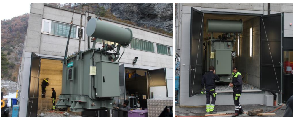
Abbildung 10: Anlieferung des Transformators für die Maschinengruppe 2.
