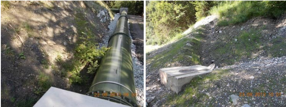
Abbildung 5: Ausschnitte aus der Hangleitung. Die Spuren der Ausbauarbeiten sind verschwunden.
