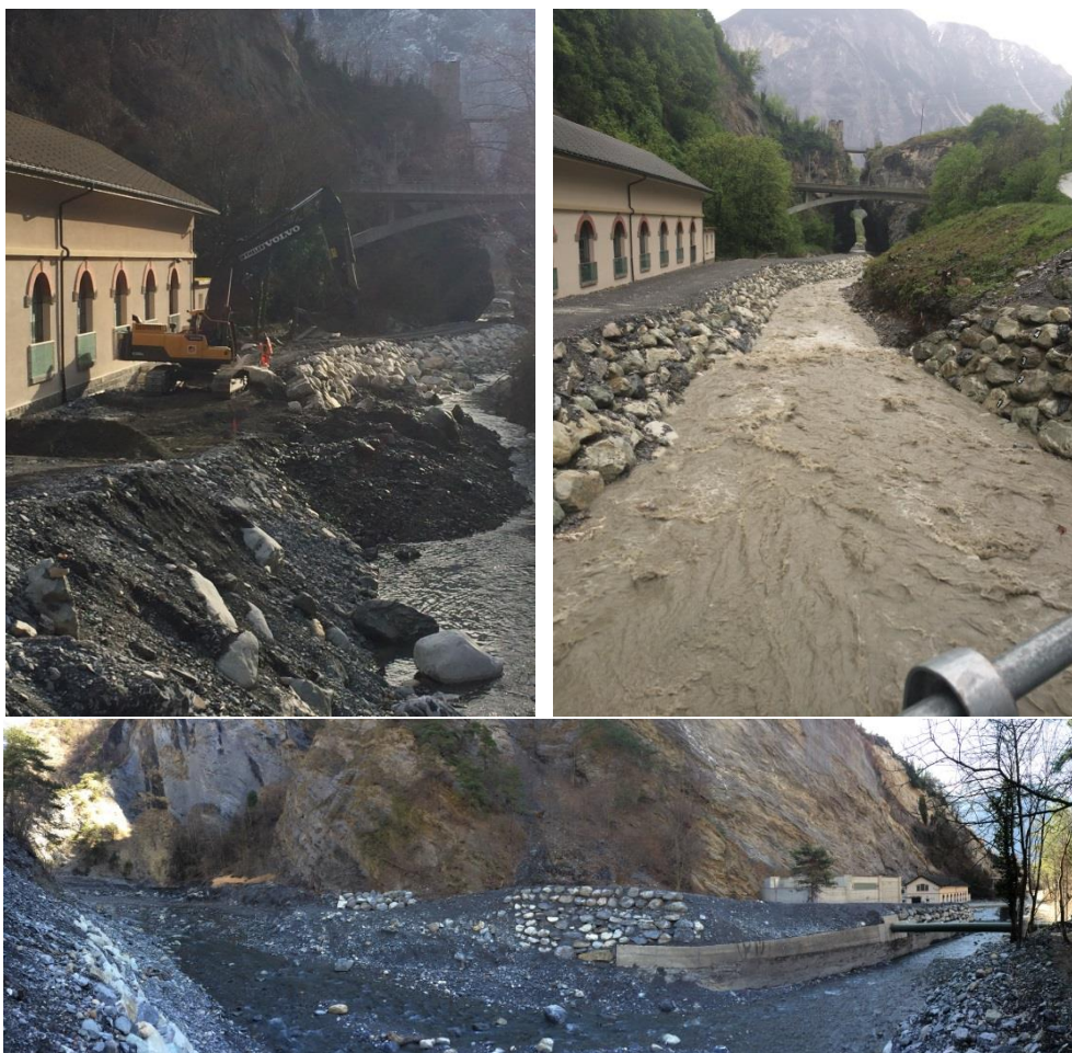
Abbildung 5: Links: Bauarbeiten zur Erstellung der Rollierungen. Rechts: Fertige Rollierungen. Unten: Ausgehobenes Auffangbacken.
