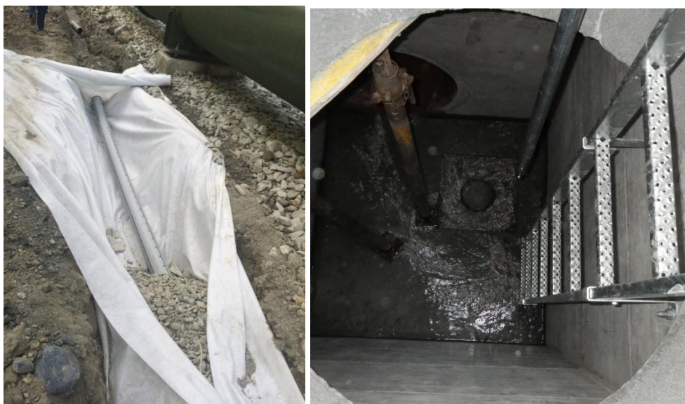
Abbildung 11: Neue Drainagen & Zugangsportale für alten Stollen.
