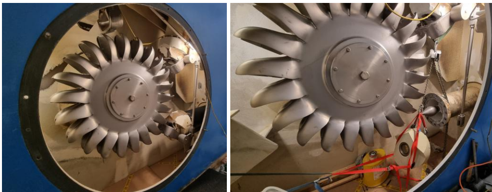
Abbildung 8 und 9: Revision MG2 und Montage Düsenhut.
