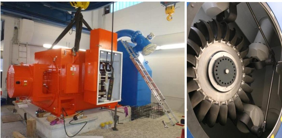
Während des Monats März 2014 erfolgte die Verkabelung des Generators, die Installation der Kühlung sowie die abschliessenden Eingiessarbeiten der Fundamente. Nach der Inbetriebsetzung im April 2014 fand die Übergabe an den Betrieb am 1. Mai 2014 statt.
